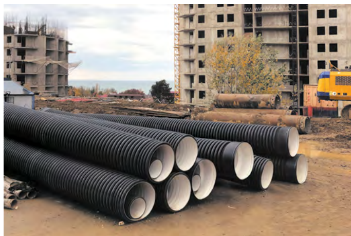
Объект: Жилой комплекс «Морская симфония», г. Сочи Подрядчик: ООО «Агора»
