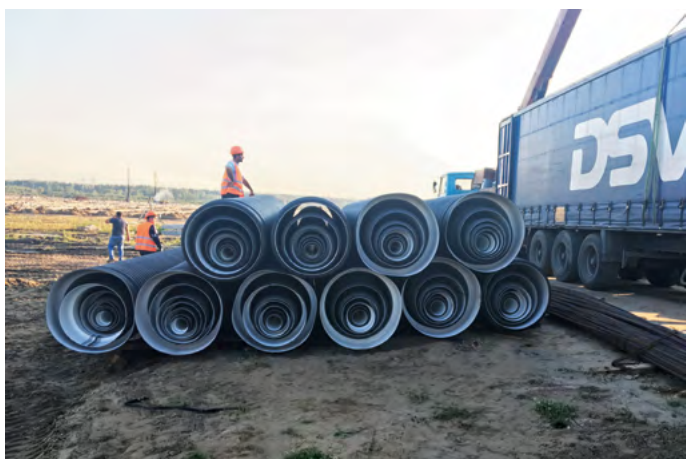
Объект: Агрокомплекс, г. Электросталь Подрядчик: ООО «ГРП ПАЙПС»
